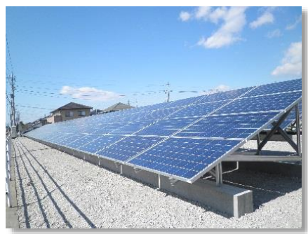
基礎/架台 (地上設置/ベタ基礎)
